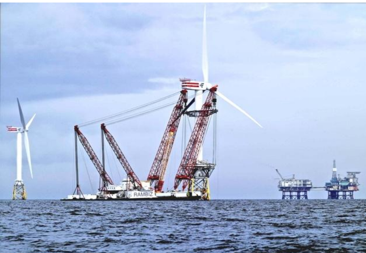
Stavba VE v moři
